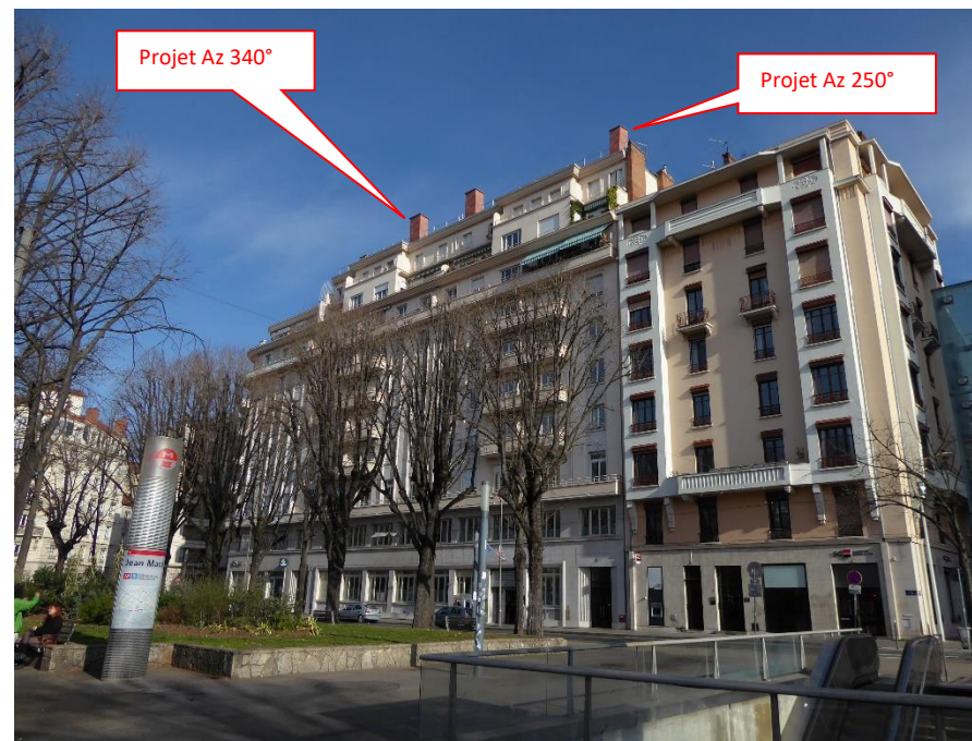
VUE 1 APRES TRAVAUX
