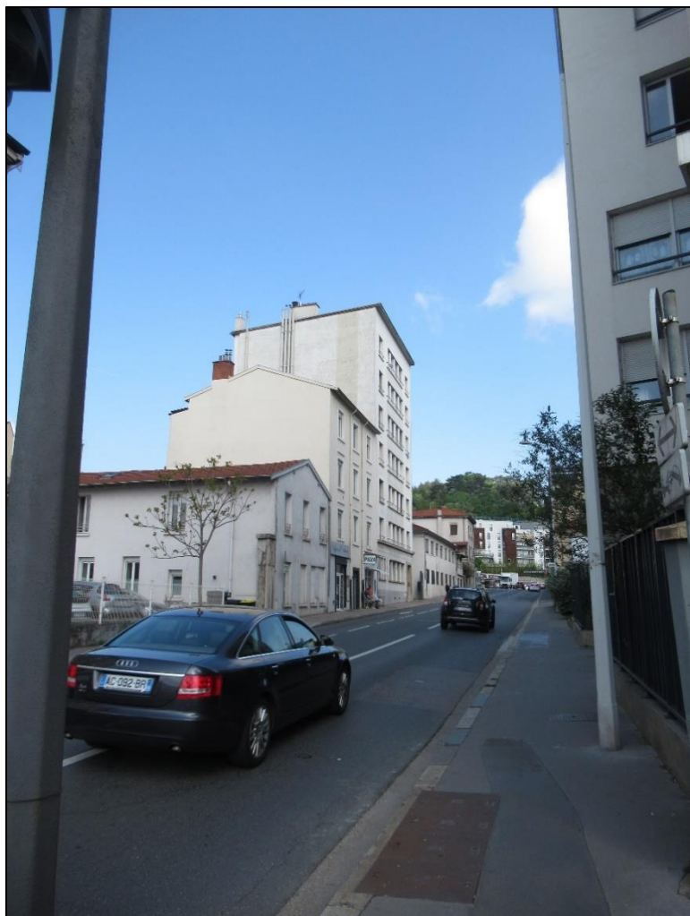
VUE 1 AVANT TRAVAUX
