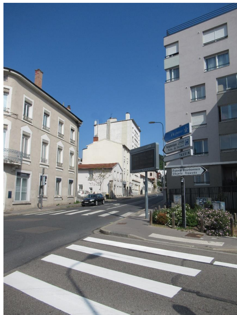
VUE 3 APRES TRAVAUX
