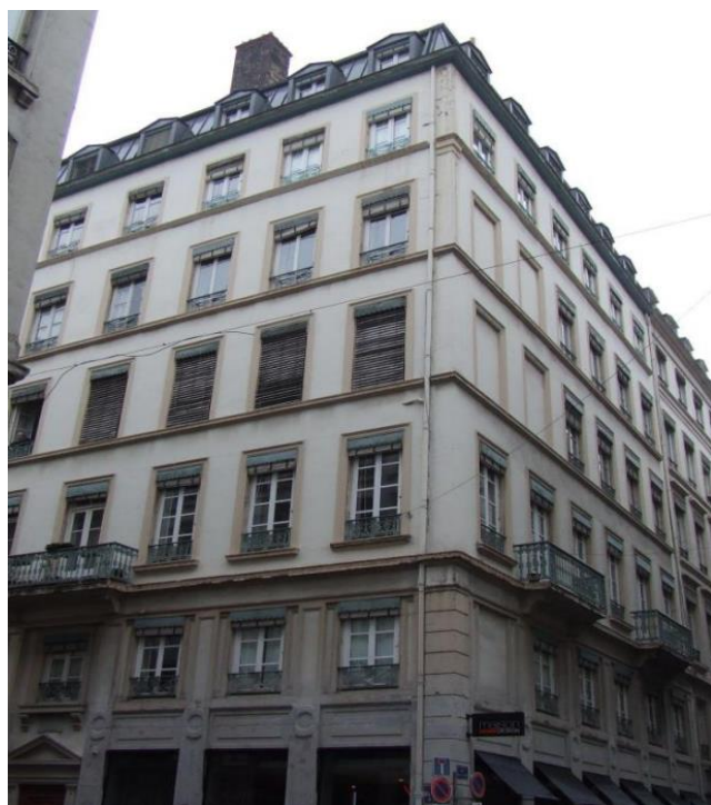
Rue 17 des remparts d'Ainay
