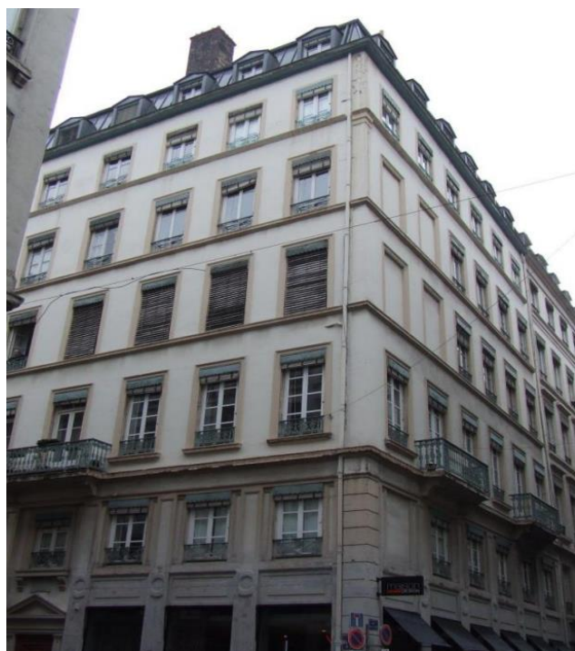
Rue 17 des remparts d'Ainay
